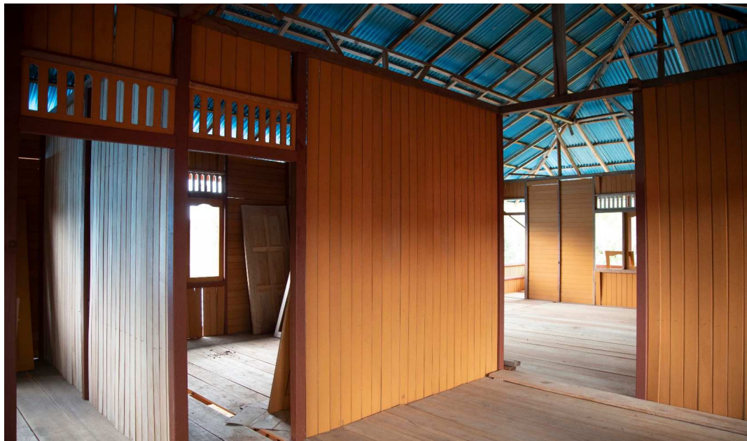
trad. Minahasa huizen in aanbouw
